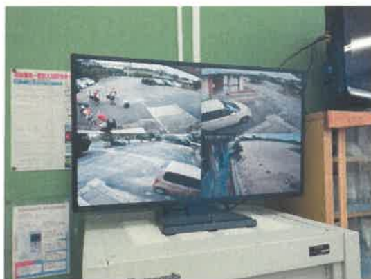
○七浦小学校 防犯カメラ設備更新工事
