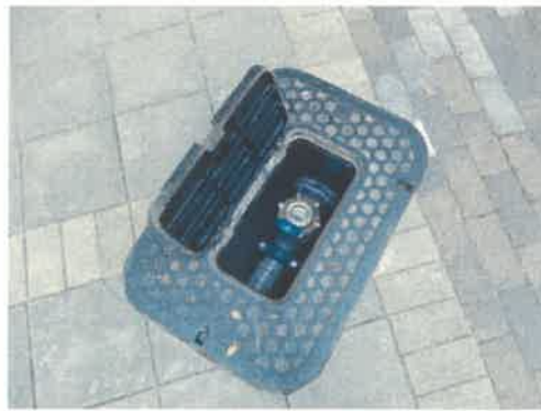
○蟻尾山公園下水道用メーター等設置
