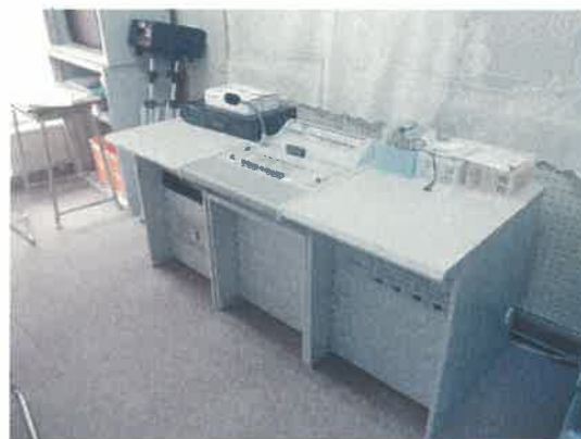
○西部中学校 放送設備更新工事
