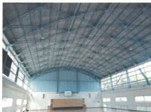
○臥竜ヶ岡体育館LED照明化
