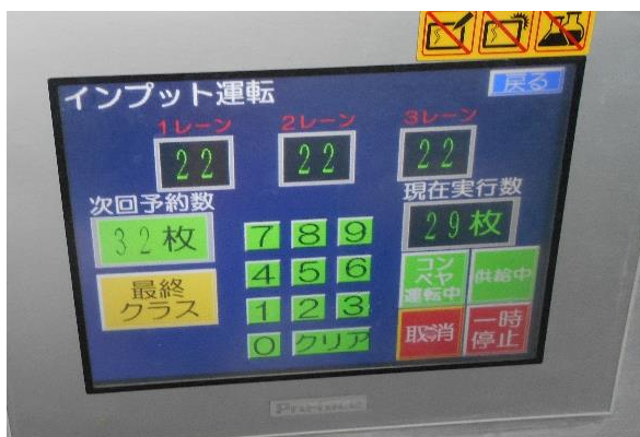
○食器洗浄機テンキーシステム交換
