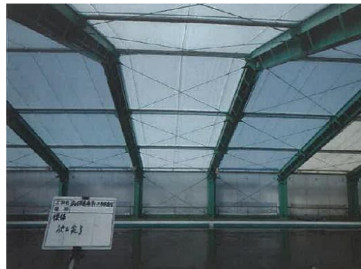
○B&G 海洋センタープール屋根改修
