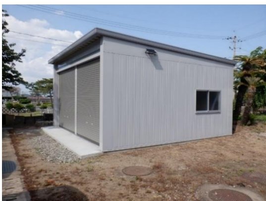
○鹿島小学校 倉庫設置工事
