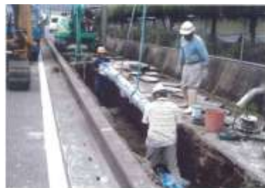
水道施設の更新工事
