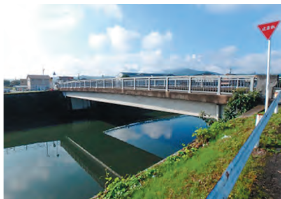
近い将来修繕が必要な橋梁の補修工事を実施
