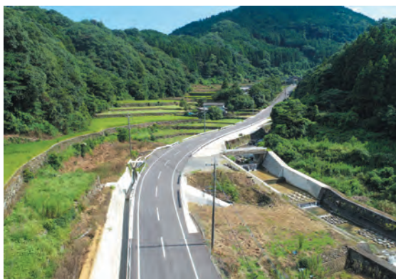
辺地道路整備
