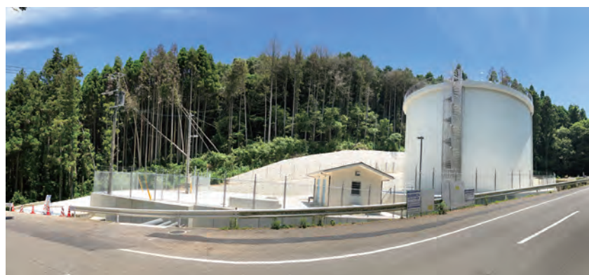
新久保山配水池
