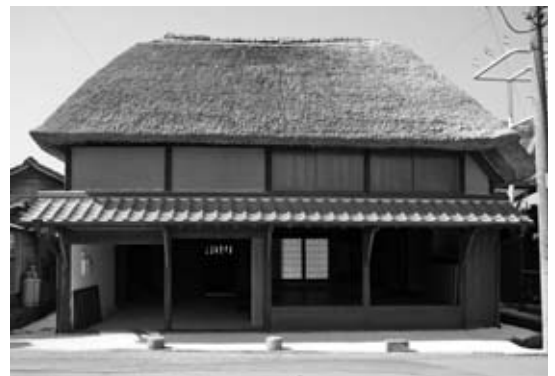
移住体験施設として改修予定の旧筒井家
