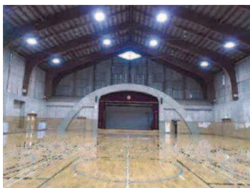
○のごみふれあい楽習館体育館 LED 照明改修
