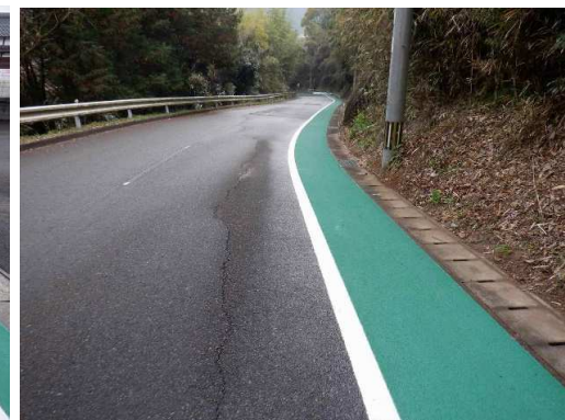
4. 能古見小学校 蟻尾山～学校 白線補修カラー舗装設置
