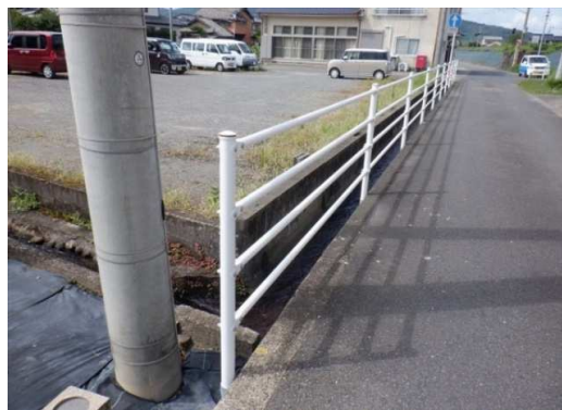
1. 鹿島小学校 中牟田公民館付近 転落防止柵設置
