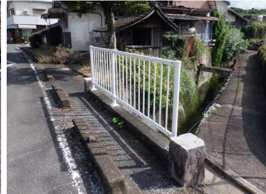
11. 七浦小学校 小宮道地区 転落防止柵設置
