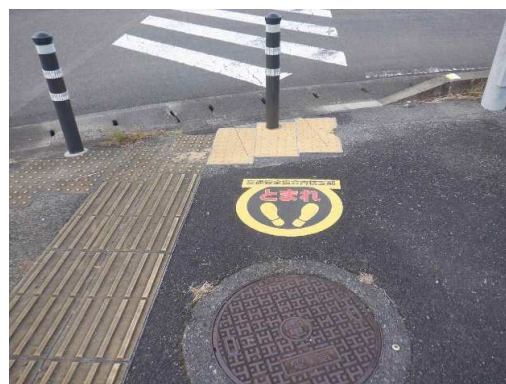
6. 古枝小学校バイパス久保山北交差 点 ストップマーク補修
