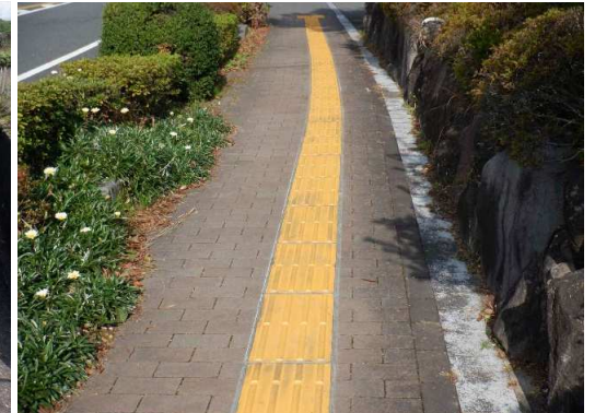
12. 明倫小学校 祐徳温泉前 点字シート補修
