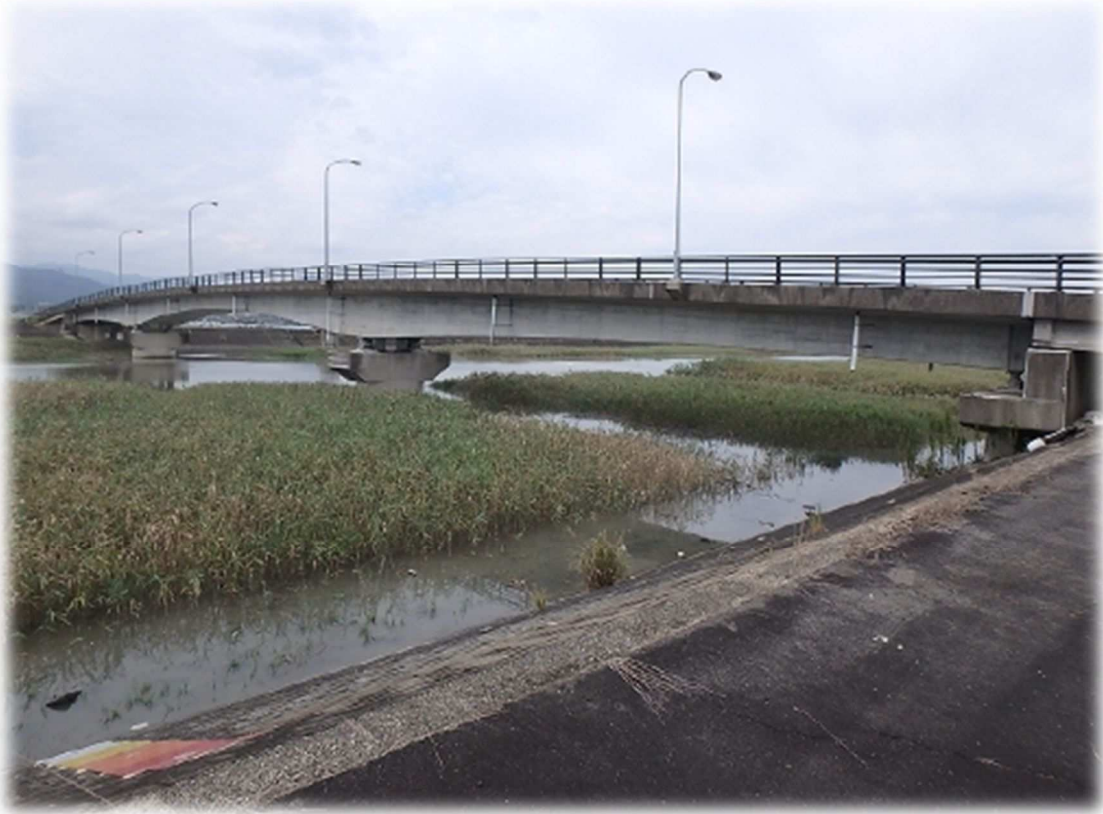
鹿島大橋 1987年架設
