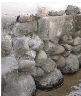
水路石積みの改修
