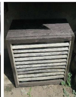
景観に配慮した木製囲い
