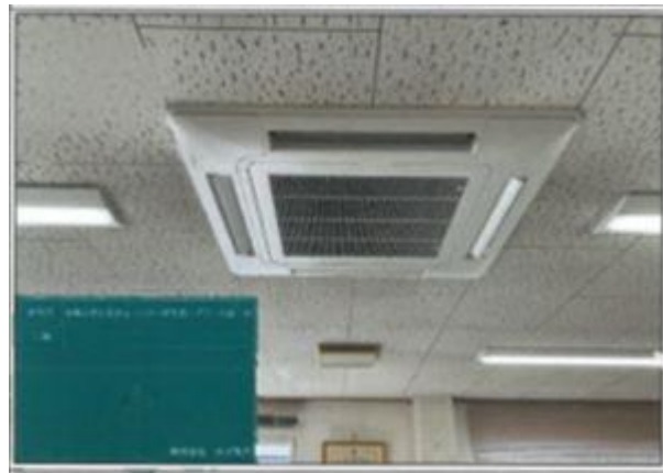
○勤労者福祉センターエアコン工事
