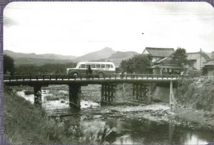
昔の写真④ 中川橋
