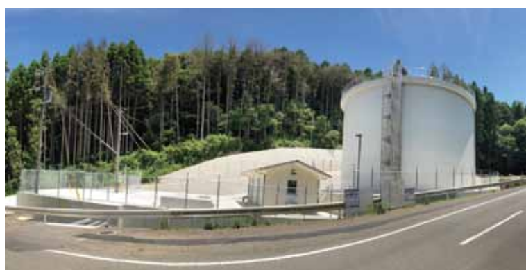
新久保山配水池
