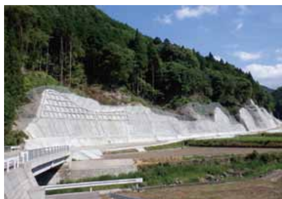
辺地道路整備(法面工事)
