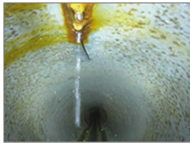
污水管渠の破損状況
