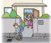
雨水ますや側溝に泥や落ち葉、ゴミが詰まると浸水の原因となります。家の近くの雨水ますや側溝の点検・清掃にご協力をお願いします。
