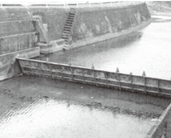
頭首工(可動堰)
