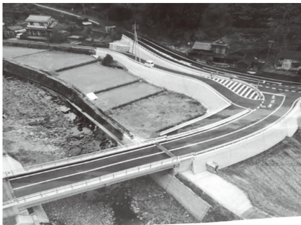
竣工した井手口橋 (三河内)
