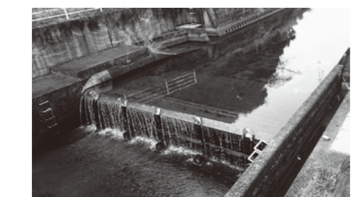
黒川水系の頭首工施設
