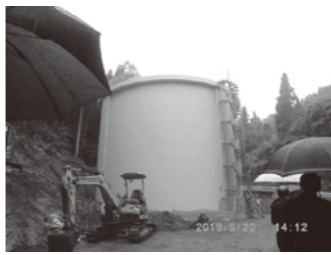
新しくできた久保山配水池
