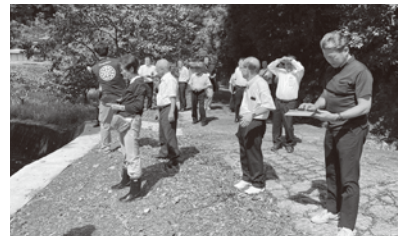
▲浅浦古湯水路整備工事
