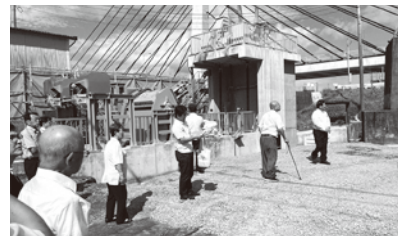
▲南舟津雨水ポンプ場建設工事
