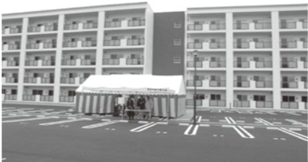
▲完成した中村住宅
