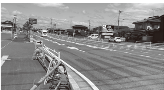
横断中の事故が発生したバイパス交差点付近
