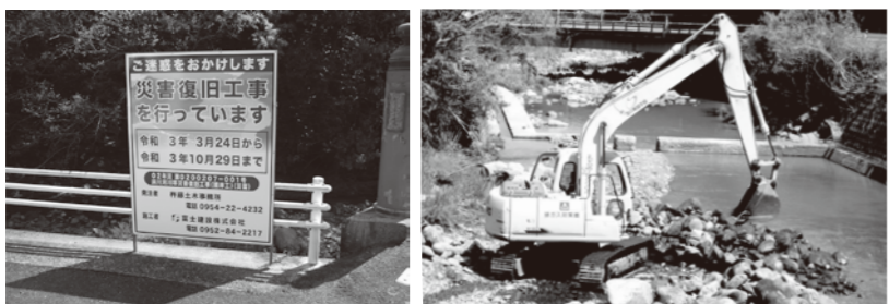
災害復旧工事(浜川上流)
