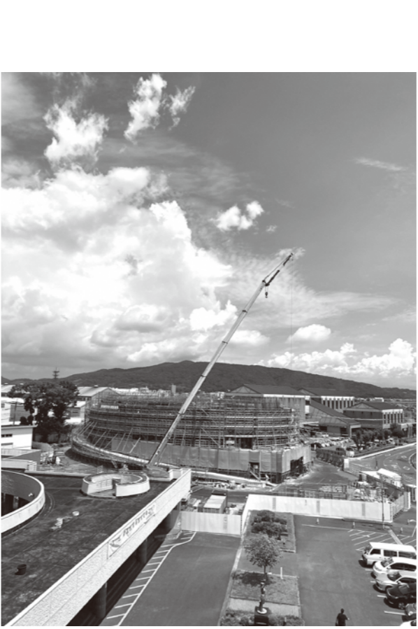
建設が進む鹿島市の新市民会館(7月7日撮影)
