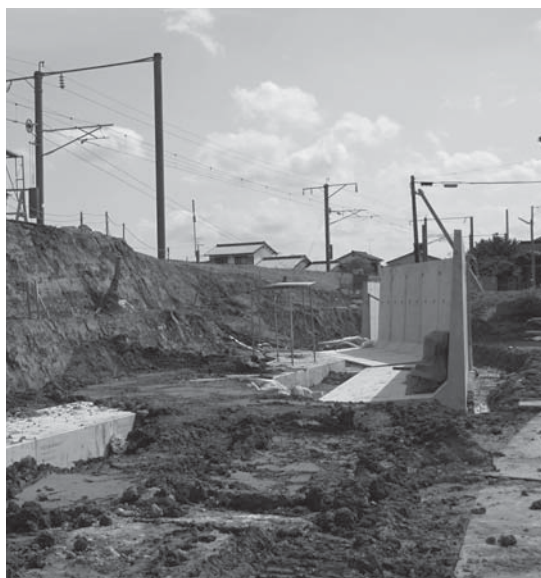
犬王袋踏切付近近道改修工事
