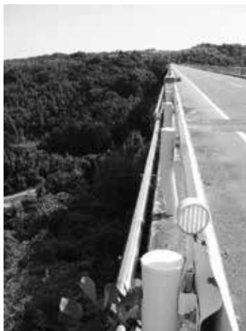
源太郎大橋沿い配水管工事
