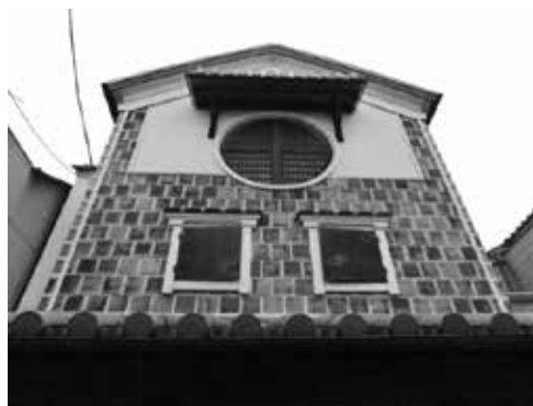
倉敷市和洋折衷建築
