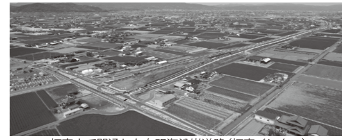
福富まで開通した有明海沿岸道路(福富インター)
