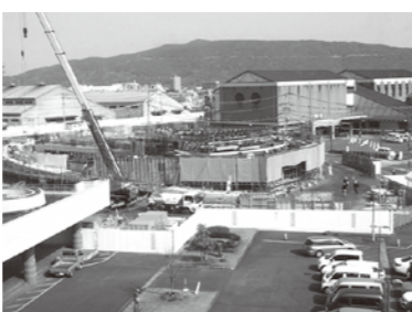
建設中の市民会館
