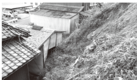
急傾斜地被災状況
