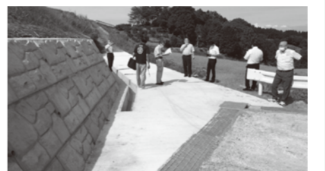
▲竹ノ木庭荒平農地道路災害復旧工事
