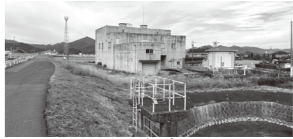
中村ポンプ場
