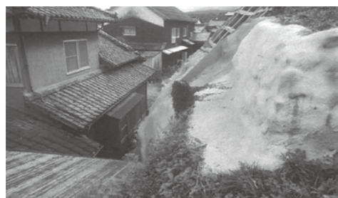
復旧工事で安全度が増した急傾斜地
