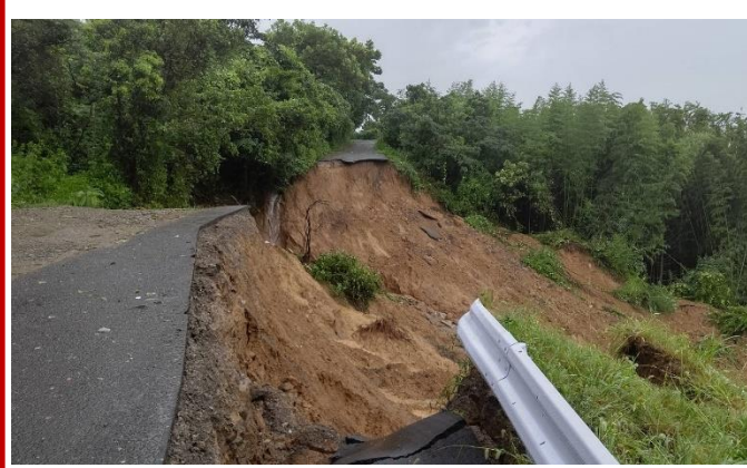
◇市道横断線崩壊（東塩屋）
