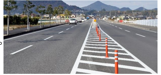
全線4車線となった鹿島バイパス(久保山交差点付近)
