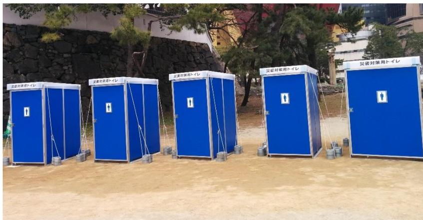
↑ 災害が発生したらマンホールの上に仮設トイレを設置します（イメージ）
