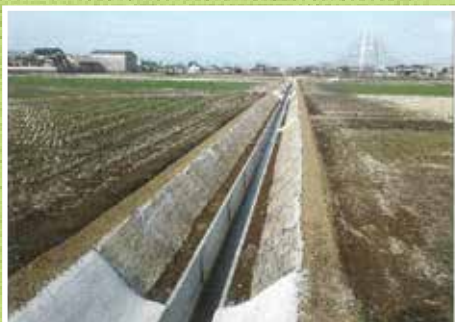
農業基盤整備促進事業 (水路整備)
