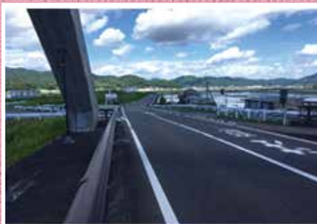
市道舗装補修事業 (中牟田・御神松線)
