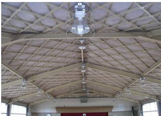
照明器具取替
