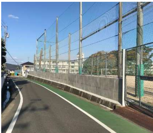
2. 鹿島高校ブロック塀撤去 コンクリート擁壁設置
