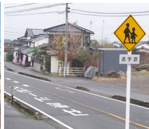
4. 能古見小学校付近 通学路標識 路面標示設置
