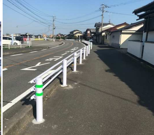
3. 能古見小学校正門前 ガードレール設置
