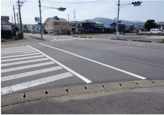
9. 西部中学校横交差点 自転車横断帯補修
