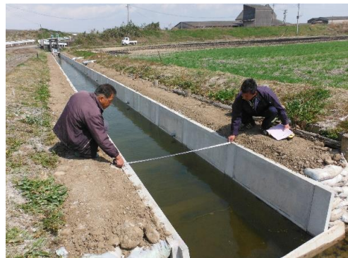
28.3.18土水路からコンクリート水路への更新 浜東部地区
