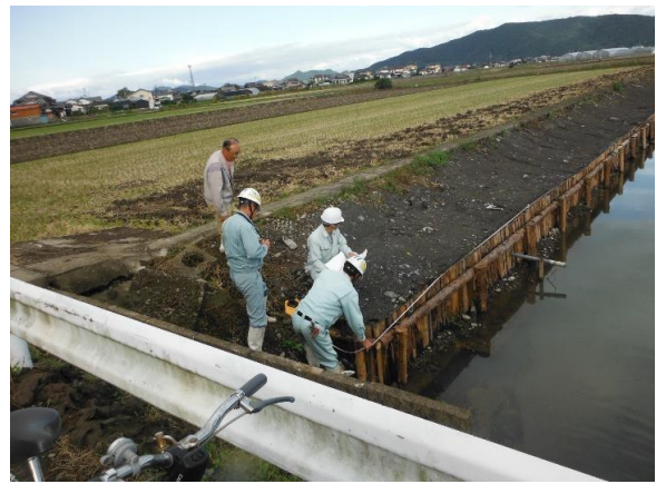
28. 11. 17 水路法面杭柵工事 小舟津
