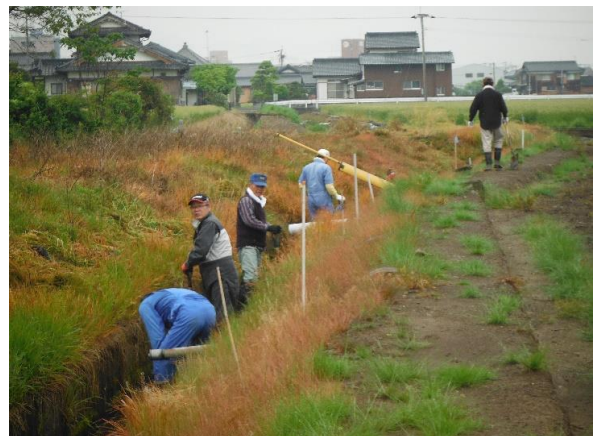
28. 4. 24水路の泥上げ 世間区
