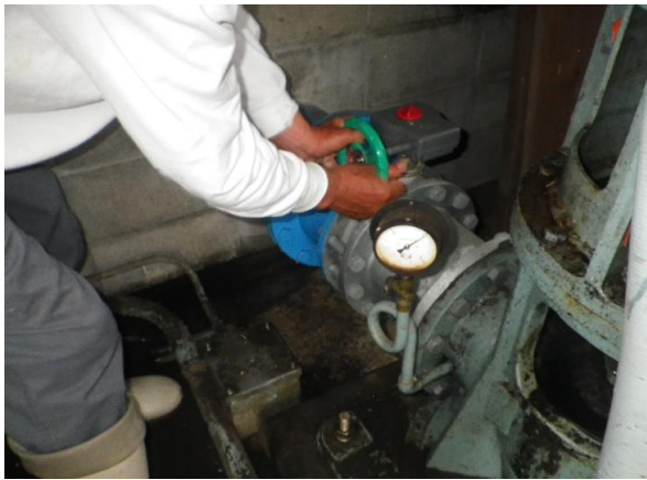
28. 5. 29 田植前のポンプ、パイプラインの点検 重ノ木区
