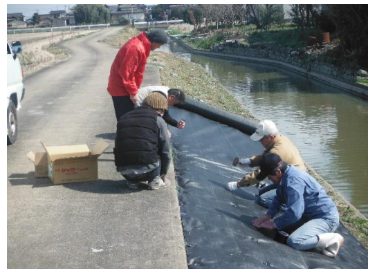
29.2.24 防草シート施工 土井丸
