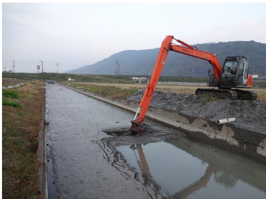
29.12.8 水路浚渫 井手
