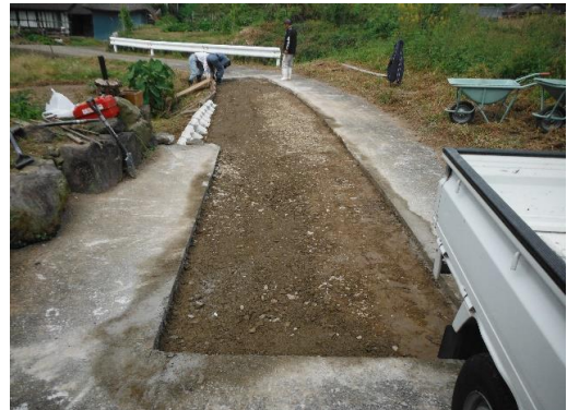
28.10.14 破損施設の補修 大宮田尾
