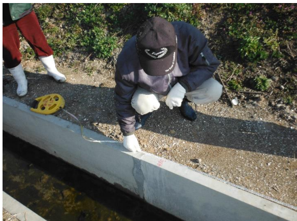
29.2.28 土水路からコンクリート水路へ更新 七浦干拓
