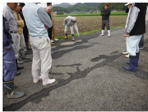
28.4.17 施設の点検・機能診断 伏原
