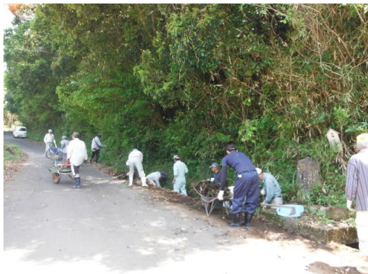
28.5.1 農道側溝の泥上げ 土ヶ
