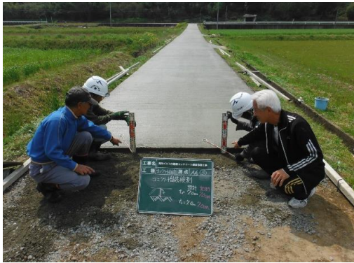
28.4.5 農道コンクリート舗装への更新 南川
