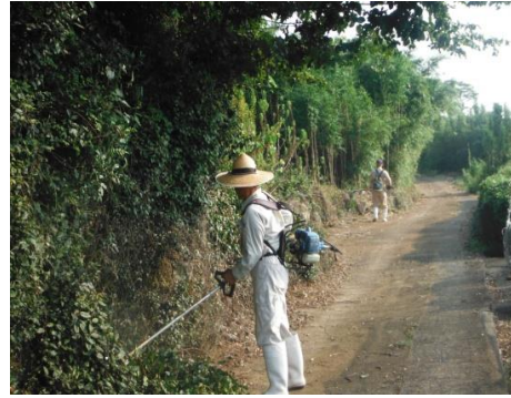
農道路肩法面の草刈り
