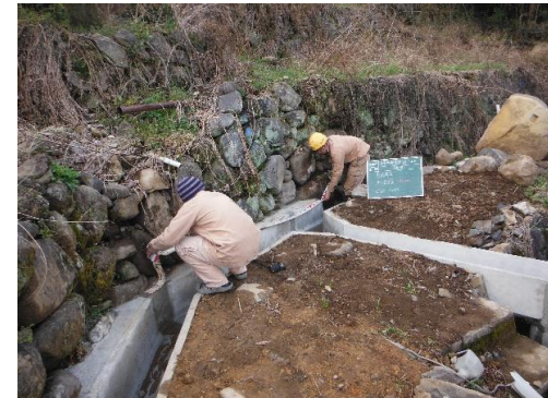
土水路からコンクリート水路への更新 完了検査 29.3.21
