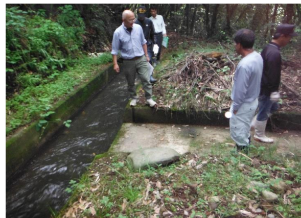
若殿分 施設の機能診断 H29.6.11
