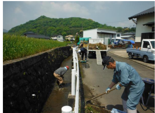
若殿分 水路の泥上げ H29.4.29
