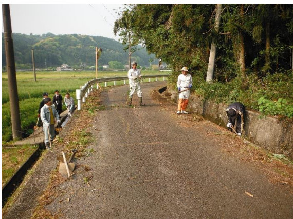
若殿分 農道側溝の泥上げ H29.4.29
