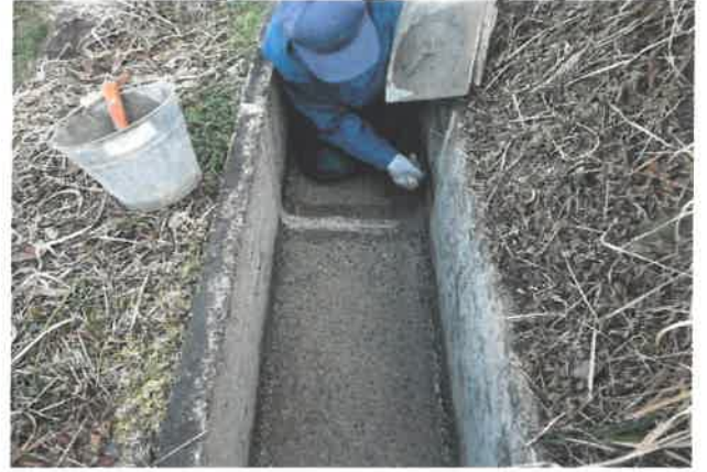
鮎越 目地詰め H31.2.1
