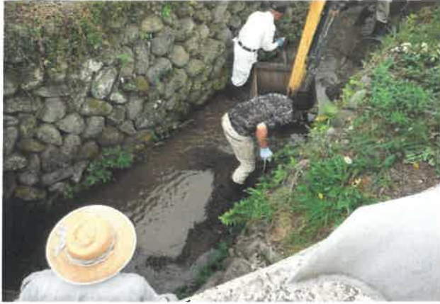
大村方 水路の泥上げ H30.5.17
