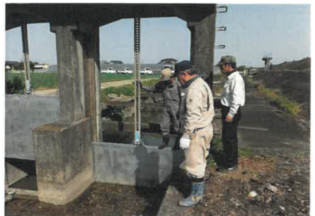
常広区 施設の点検・機能診断 H30.4.8
