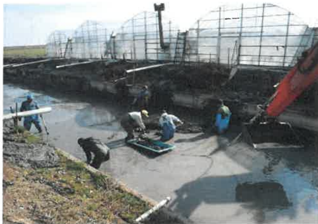
三部区 水路の泥上げ H30.12.22
