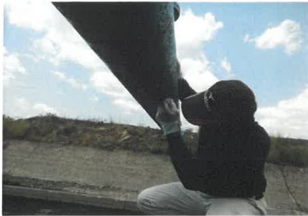
中村区 送水管補修 H30.5.4
