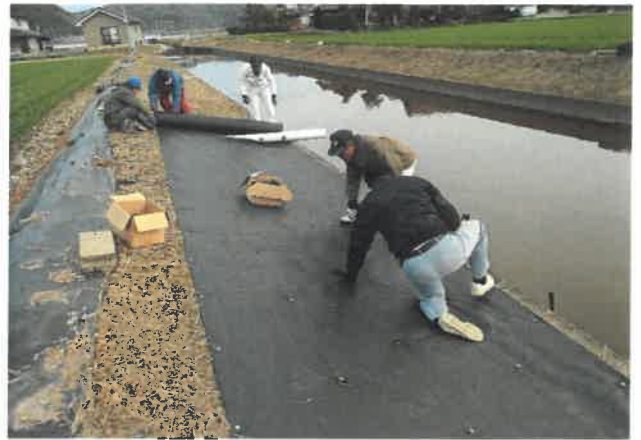
井手区 防草シート設置 H31.2.20
