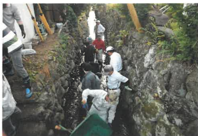
大殿分 水路の泥上げ H30.6.3
