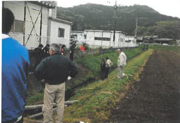
伏原 施設の点検・機能診断 H30.4.15
