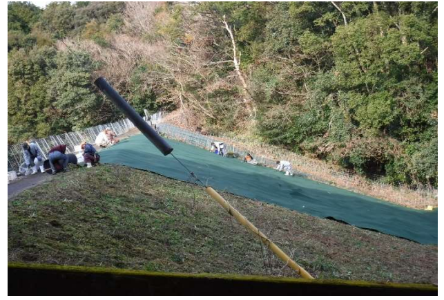
嘉瀬の浦 ため池防草シート張り R2.1.19
