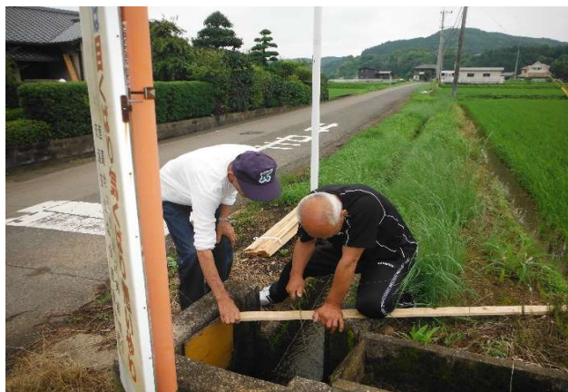
若殿分 水路附帯施設の補修 R1.6.4
