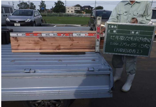
若殿分 堰板の取り替え R2.7.8
