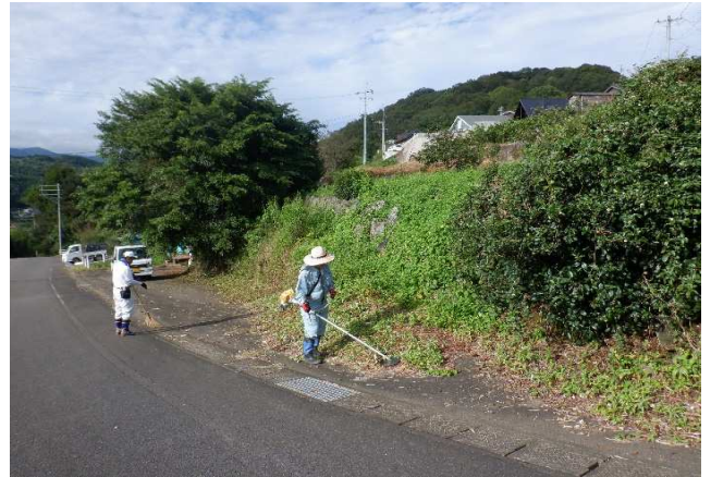
若殿分 路肩法面の草刈り R2.9.13
