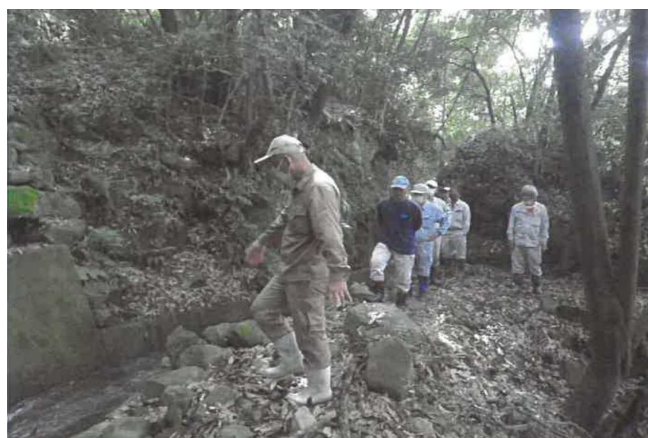
若殿分 施設の機能診断 R3.6.6
