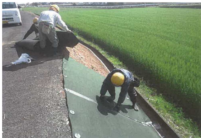
若殿分 防草シート設置 R4.3.16
