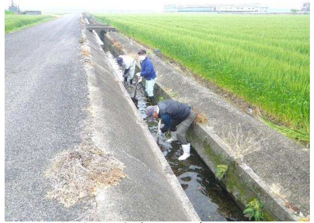
重ノ木区 水路 泥上げ R4.4.23
