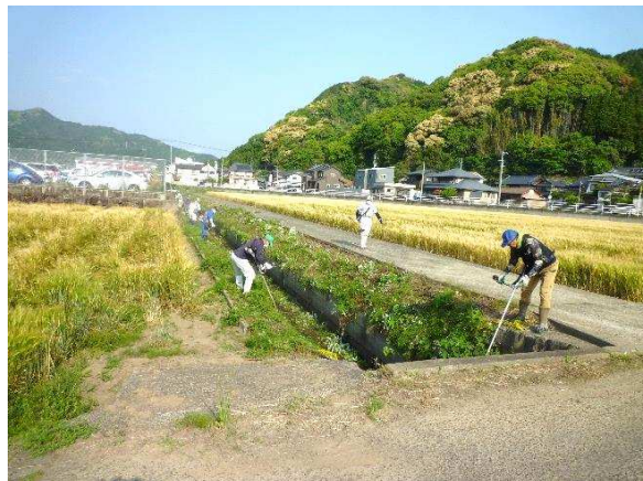
幹線水路 水路 草刈り・泥上げ R4.5.8
