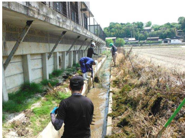
西葉区 水路 泥上げ R4.5.8
