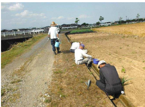
南川区 水路 目地詰め R4.5.8
