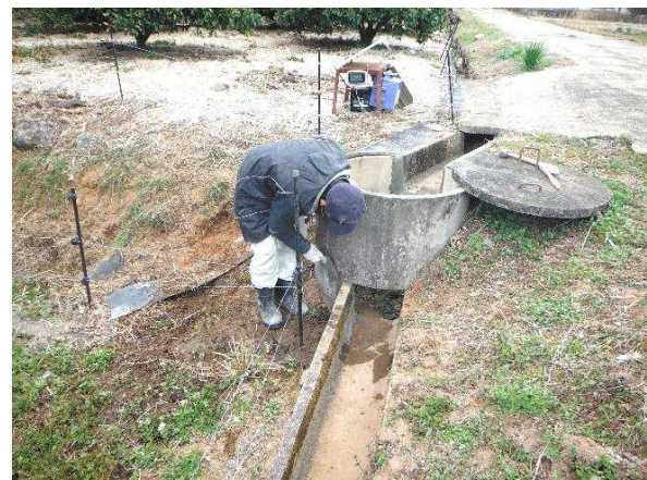
大殿分区 水路 軽微な補修 R5.2.23
