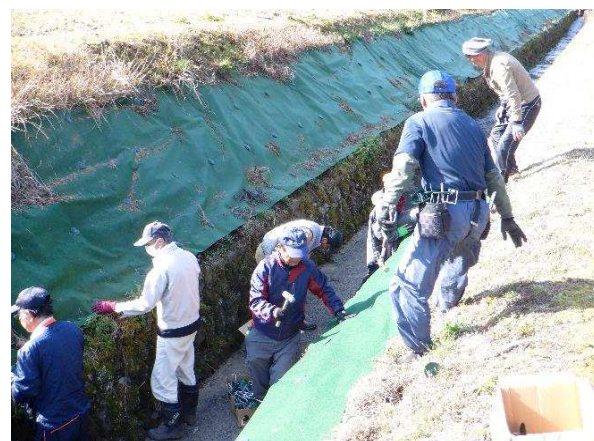
上浅浦区 防草シート張り R5.3.5
